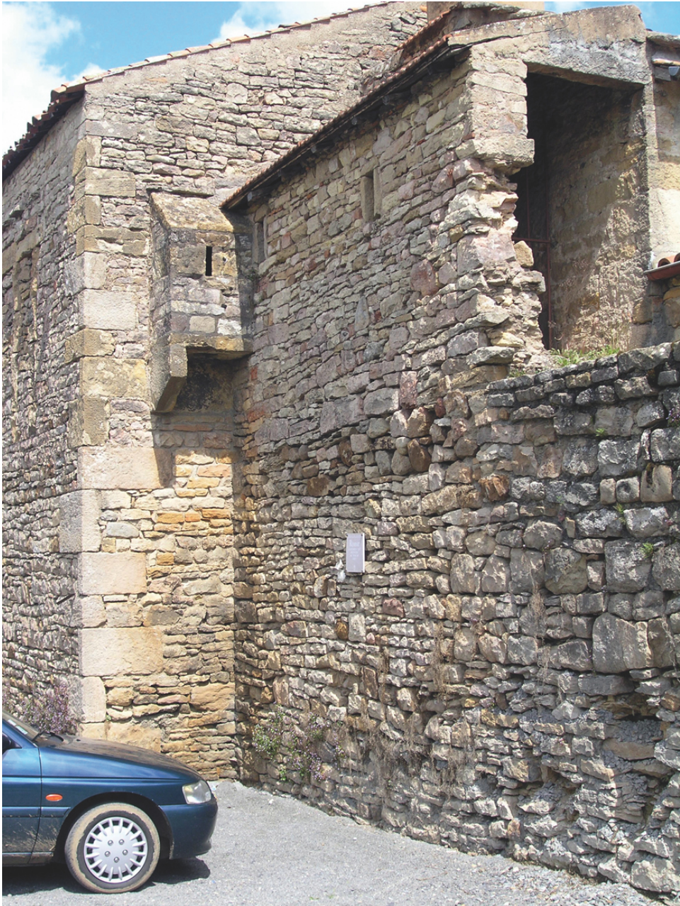
Abbildung 6.17: Cluny, westliche Stadtmauer. Außenseite mit Wehgang und Latrinenerker nahe dem Eintritt des Médason in die Stadt.
