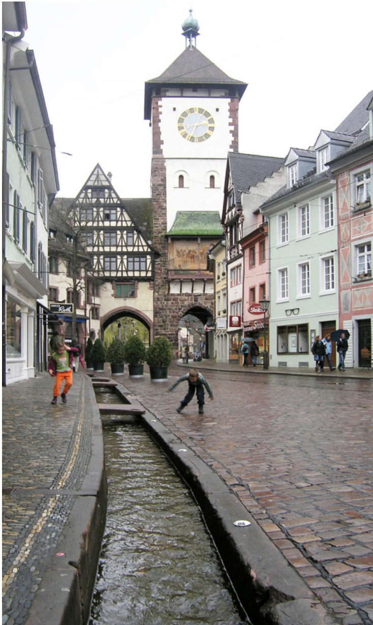
Abbildung 7.12: Die Nachhaltigkeit hochmittelalterlicher Stadtanlagen liegt wesentlich in der Berücksichtigung topographischer Vorbedingungen begründet. Dies ist eine Vorgabe des Corpus agrimensorum , das in der Zeit um 1100 stark rezipiert wurde. Ein Fallbeispiel sind die Freiburger „Bächle“, ein innerstädtisches Kanalnetz, dessen Anlage die Ausrichtung der Straßen nach dem natürlichen Gefälle der Stadtfläche bedingte.
